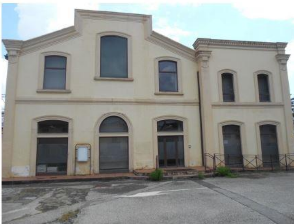
VISTA PROSPETTO FRONTALE FABBRICATO 1
