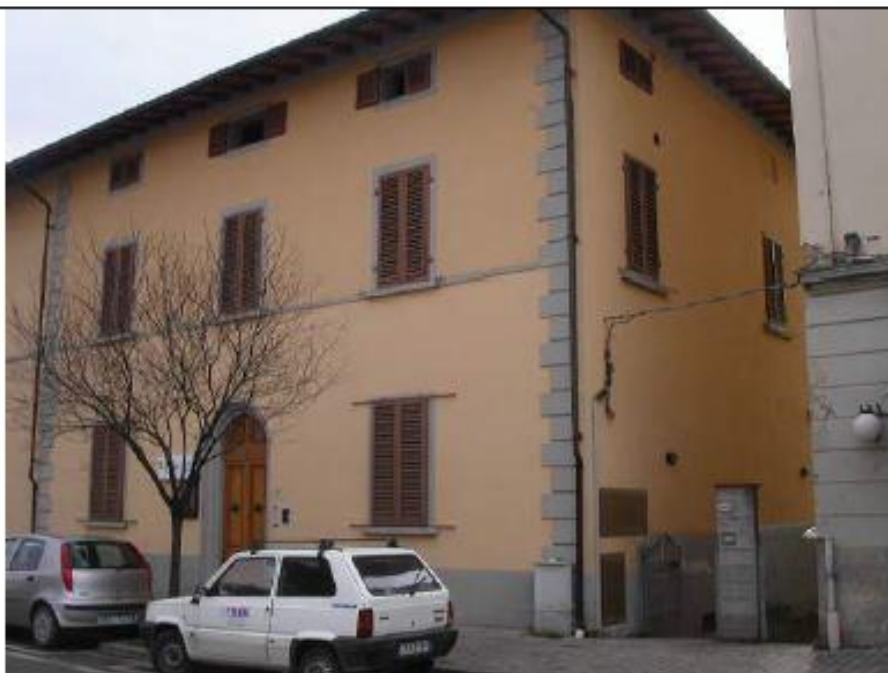
Foto n. 1 - Fronte principale dell'edificio posto in Via Diaz 189
