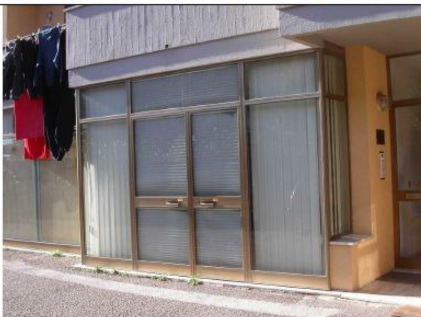
Foto n. 2 – Accesso secondario dal lato est dell'edificio
