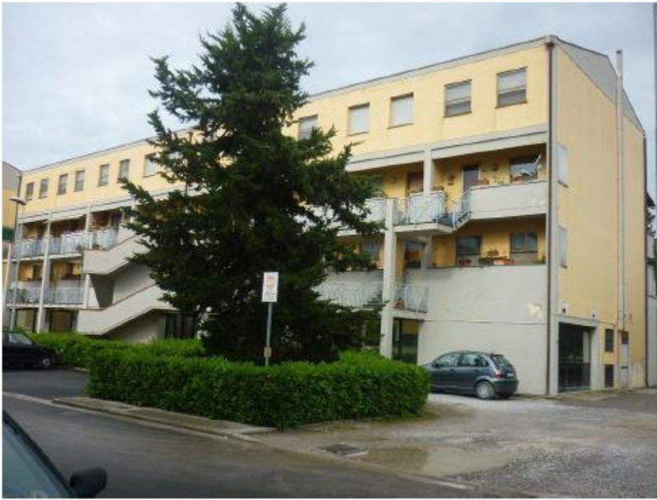
FOTO n. 3 – Fronte Nord-Est dell'edificio
