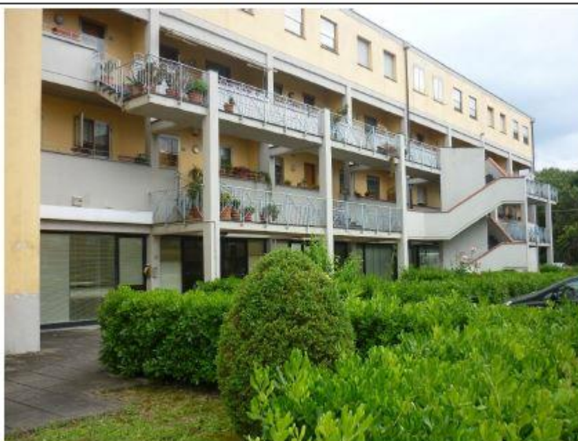
FOTO n. 2 – Fronte est dell'edificio
